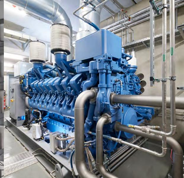
Oben: Autarke Versorgungseinheiten für redundanten Rechenzentrumsbetrieb.
