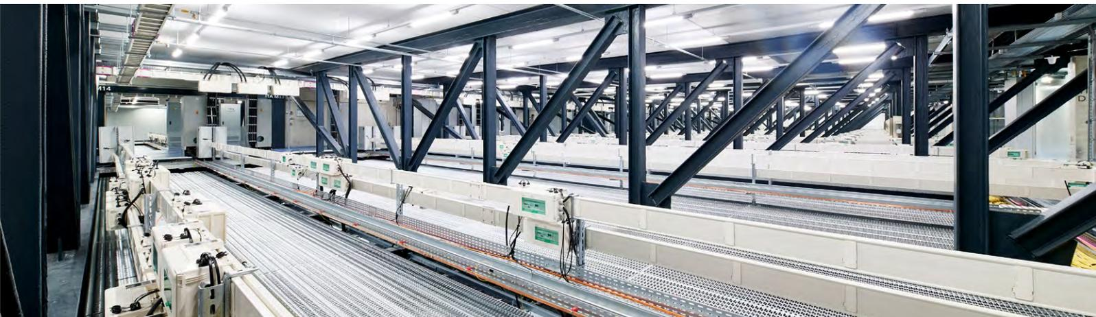
Die gleichmäßige Verteilung der gekühlten Luft ermöglicht die Belegung des drei Meter hohen begehbaren Deckenbereichs mit wärmeunempfindlichen Systemen: Cloud-on-Top.
